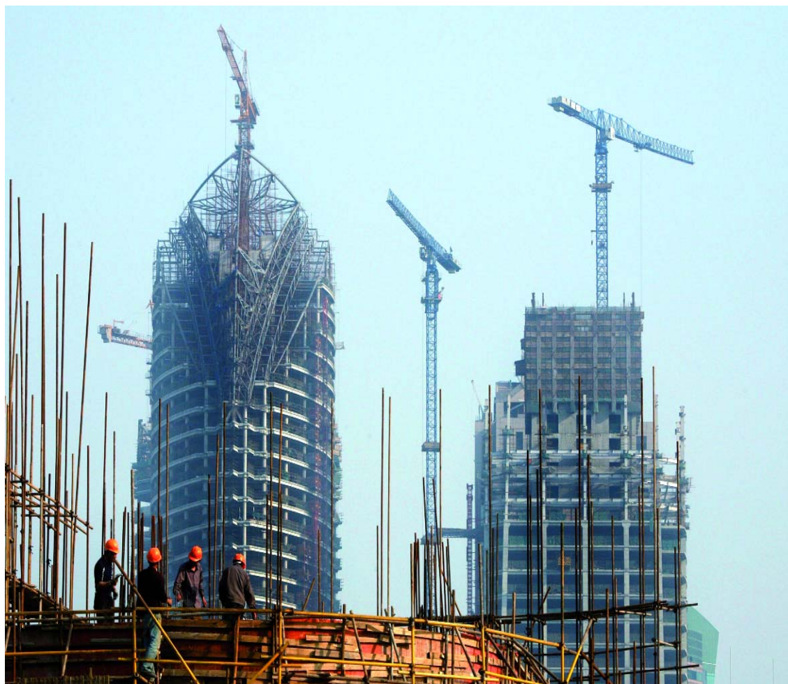
Operai al lavoro per la costruzione di un edificio del Mtn Sundome, Graeme Williams/South Photographs/Africanpictures.net/Archivi Alinari, Firenze
