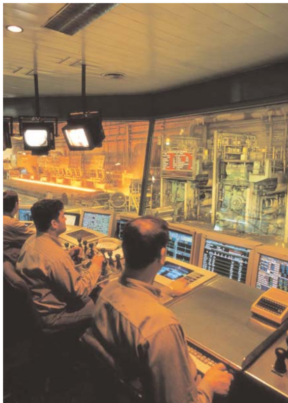
La sala di controllo del laminatoio a caldo dello stabilimento Ternium di San Nicolás
