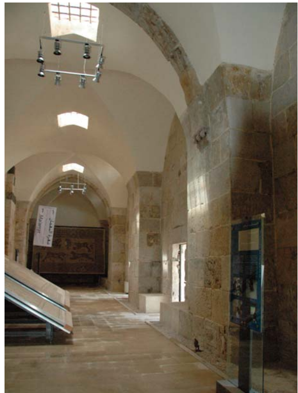
Riabilitazione e riutilizzo della Cittadella di Damasco: Galleria Nord, disegni di progetto e varie fasi di realizzazione.
