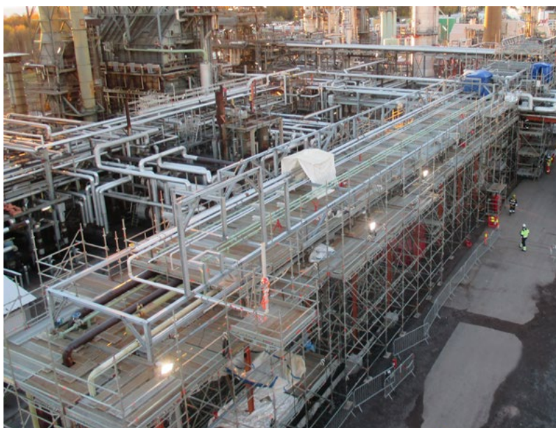
■ Un particolare del cantiere di Irem presso la Raffineria Esso Norge di Slagen
