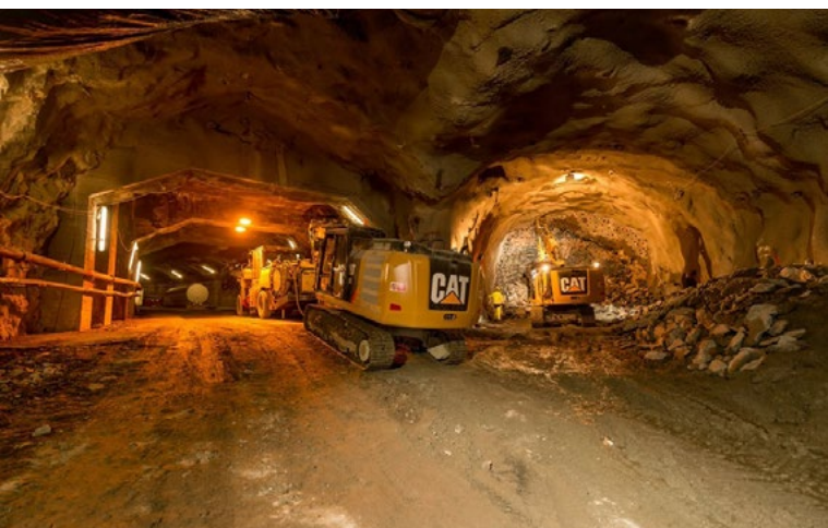
■ Una delle gallerie realizzate da Condotte a Oslo
