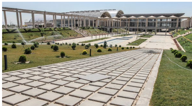
■ Uno dei progetti immobiliari in fase di costruzione a Teheran
