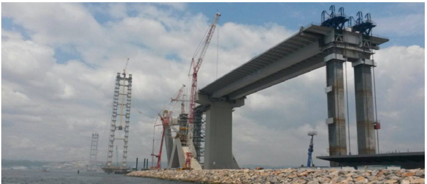
I lavori per la costruzione di una delle campate dell'Izmit Bay Bridge ■
