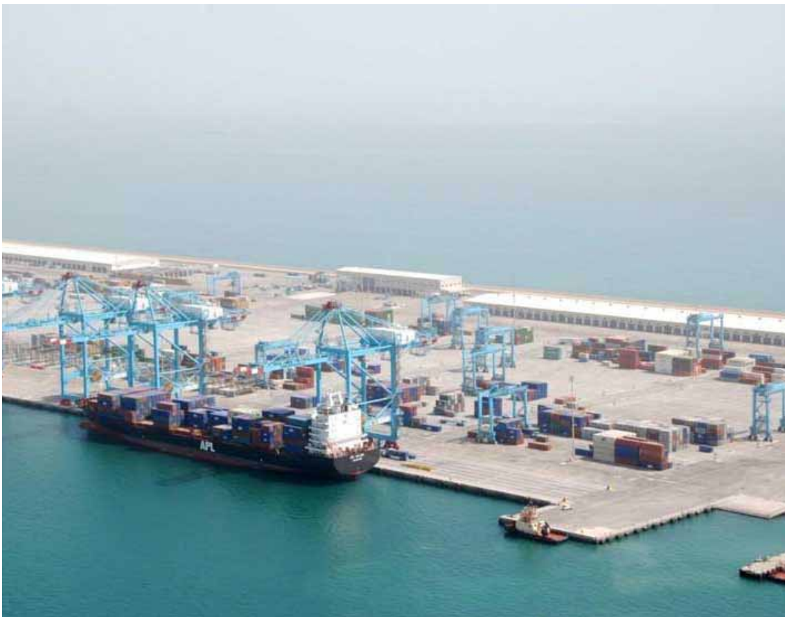
Khalifa Bin Salman Port - Una portacontainer impegnata nelle operazioni di scarico
