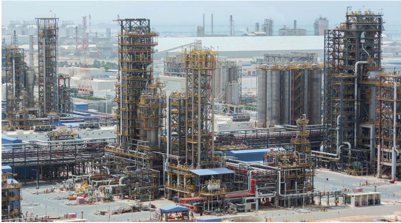
■ La raffineria di Ruwais
